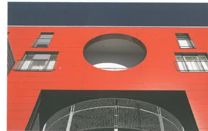
Die neue vorgehängte hinterlüftete Fassade wurde mit Alucobond-Verbundplatten realisiert.
